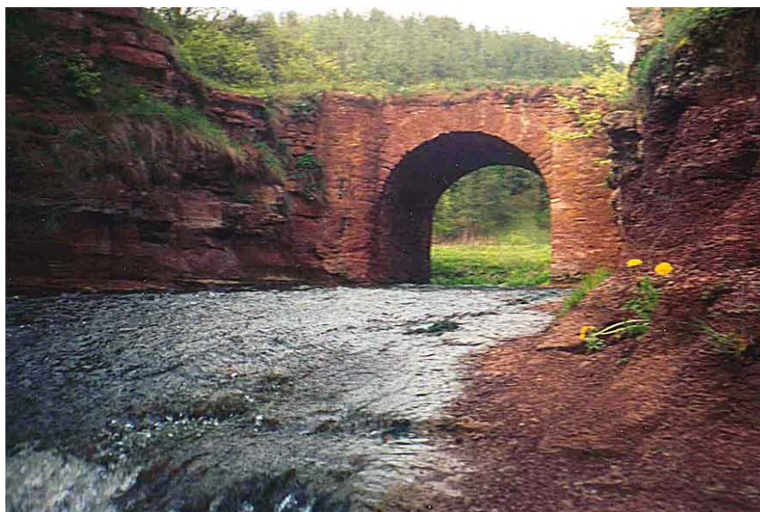
(a) Міст-«віадук» над водоспадом.
