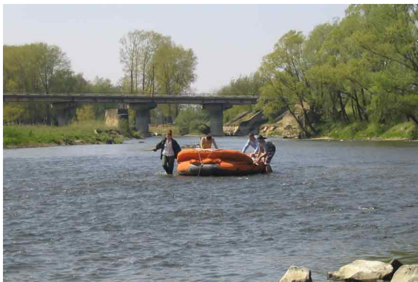
Фото 5.1. Міст через р. Бистриця в с.м.т. Єзупіль.
