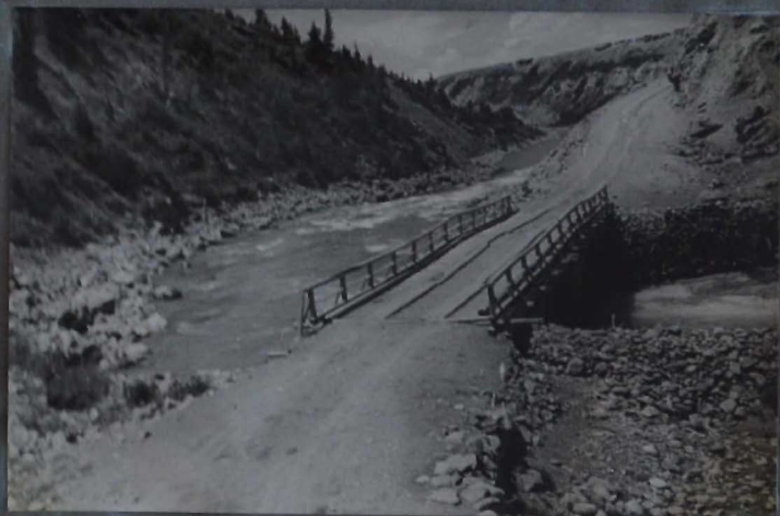
Мост в районе Болого через Ат Башы
