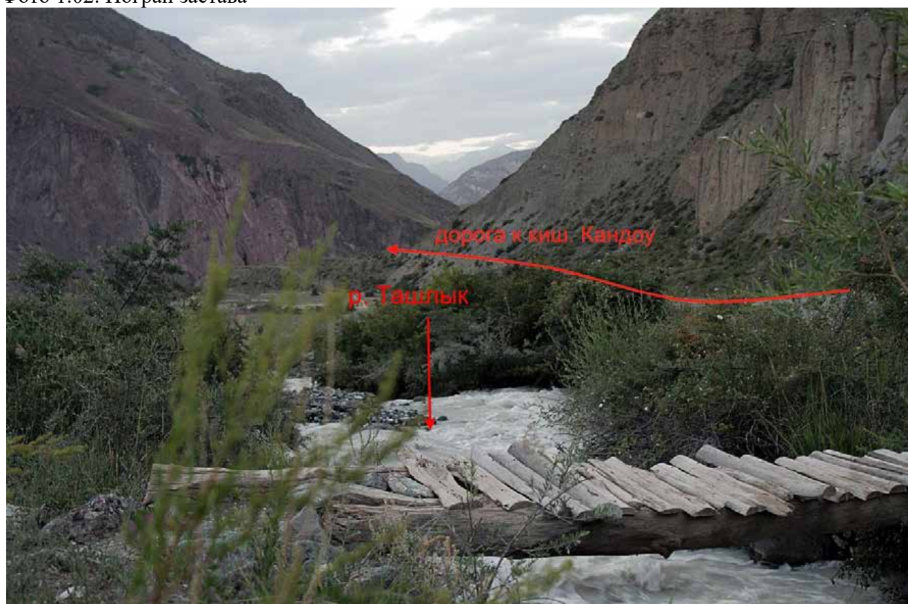
Фото 1.03. Мост через р.Ташлык
