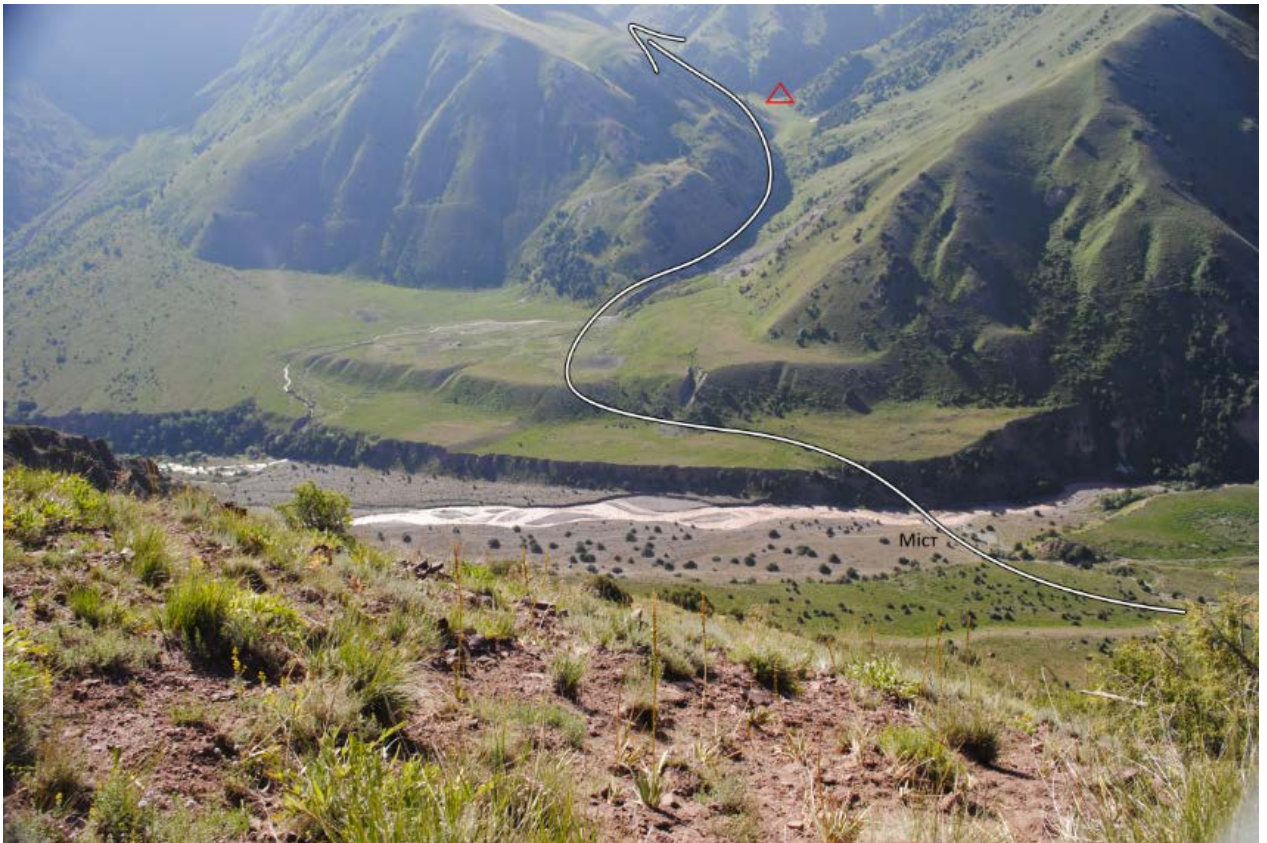
Фото 19. Зруйнований міст в д.р. Кель-Дук
