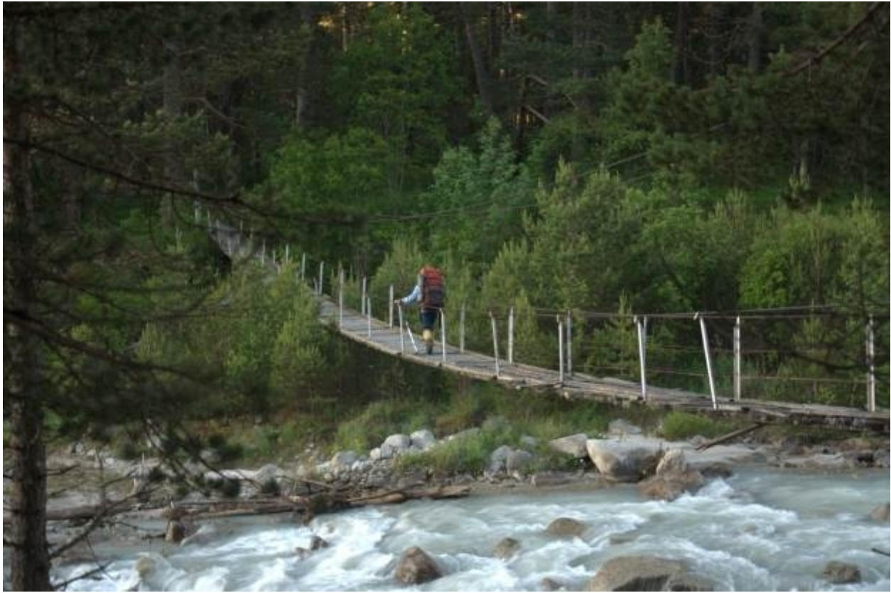
Фото 5.3. Мост через Башиль-Аусу.
