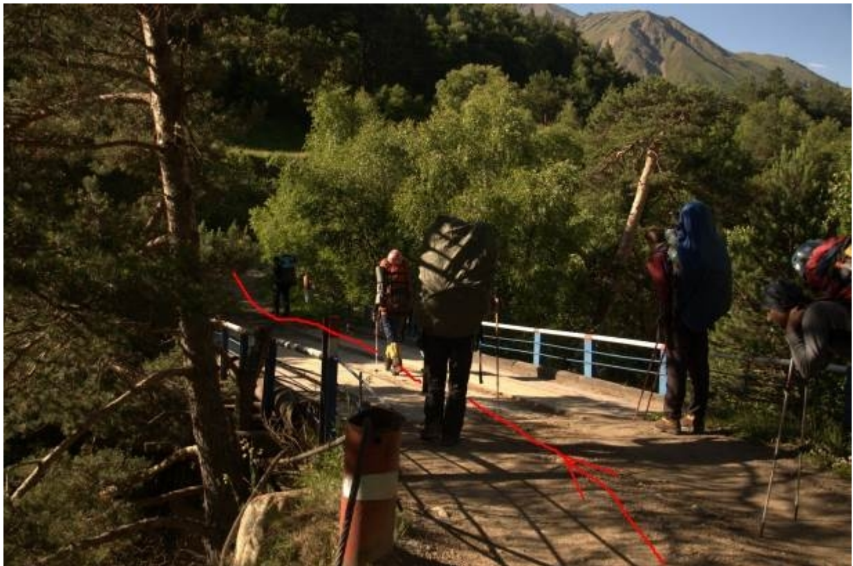
Фото 5.6. Автомобильный мост через р. Гара-Аузсу
