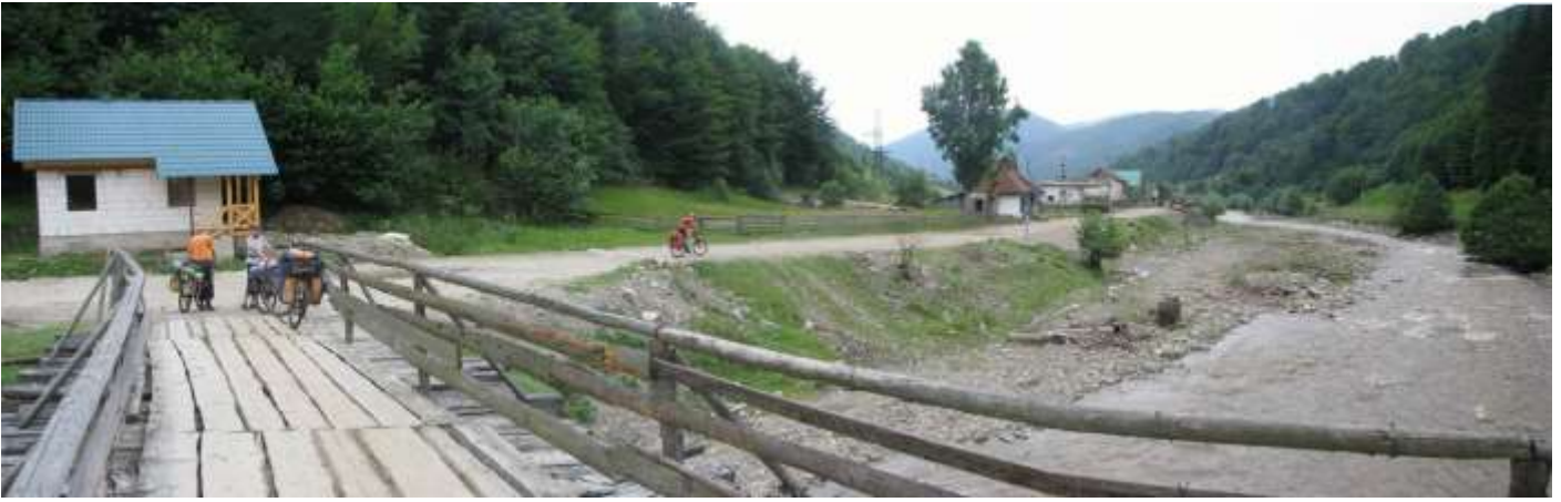
Ф36. На мосту через р.Мокрянка
