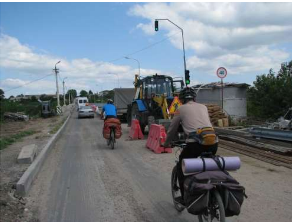
Ф127. Ремонт мосту через Дністер між с.Атаки і с.Жванець
