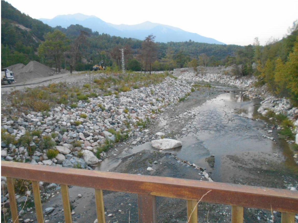
Фото 7.10 Міст через річку
