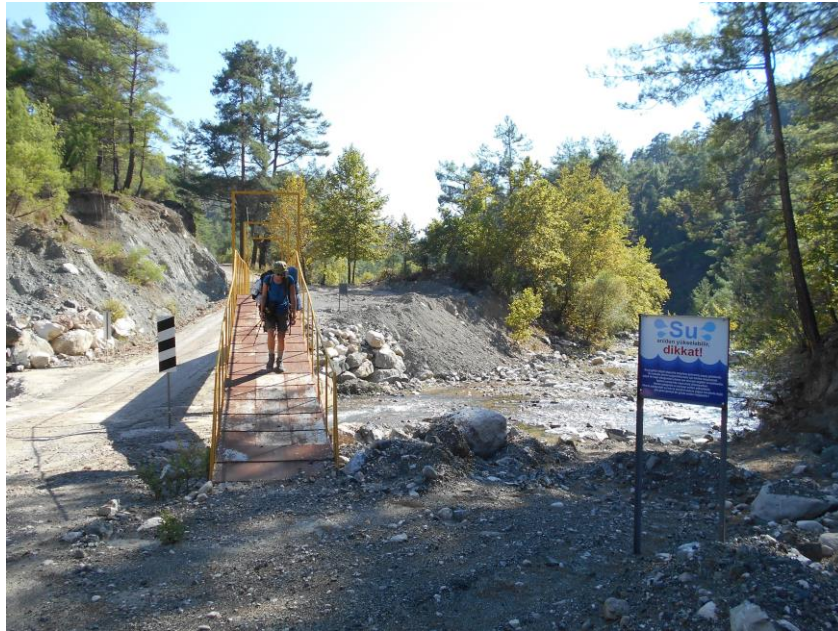
Фото 8.3 - Міст через річку
