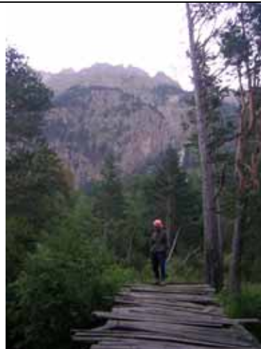
Фото 61. Мост через Аксаут
