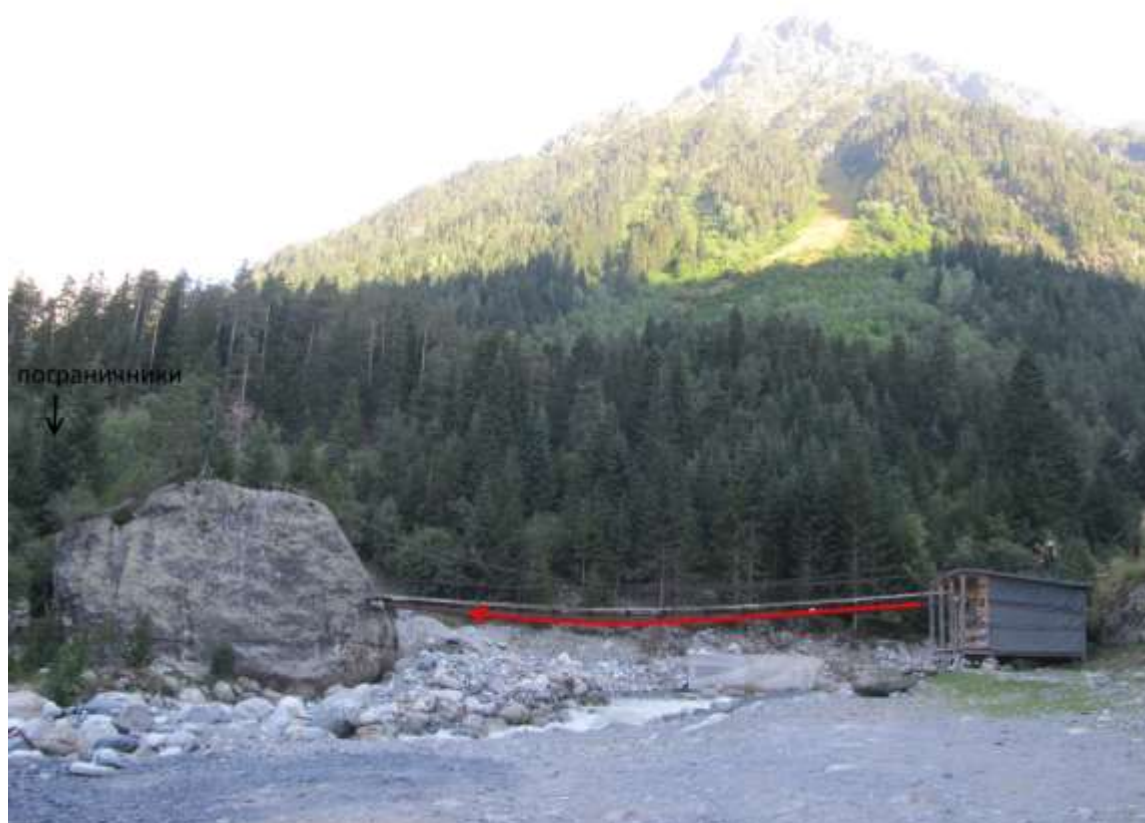
Фото 4.3. Навесной мост через р. Местиачала
