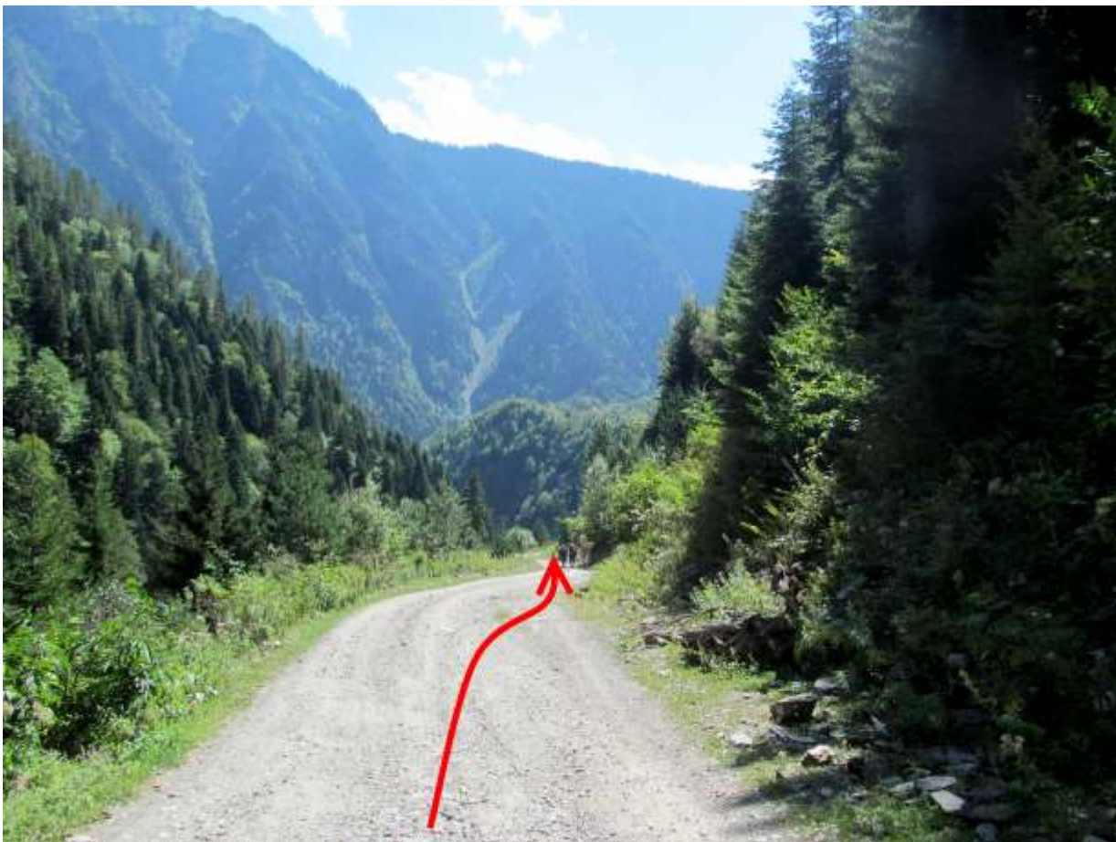
Фото 14.3. Грунтовая дорога по правому берегу р. Накра (от с. Наки к трассе)
