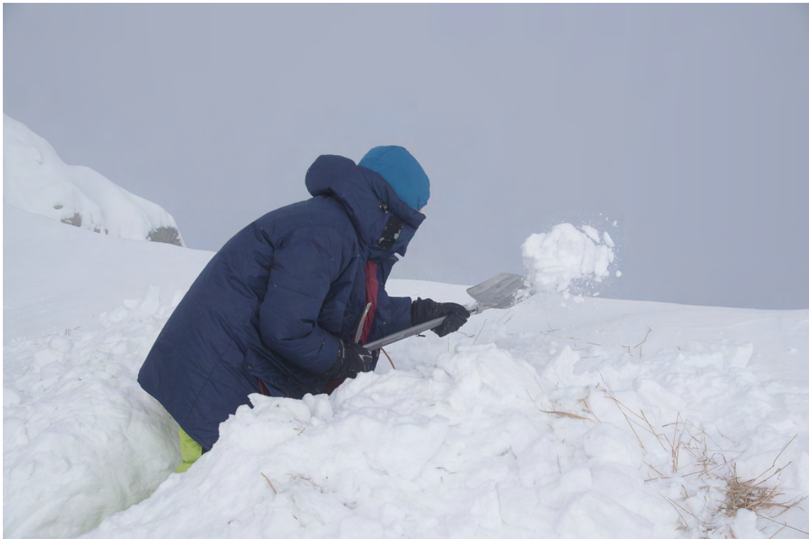
Фото 3.10 - Підготовка траншеї для колоди
