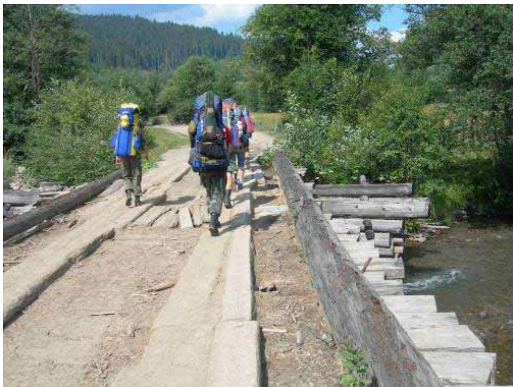
Фото 2.2 – Міст через р. Чорна Тиса
