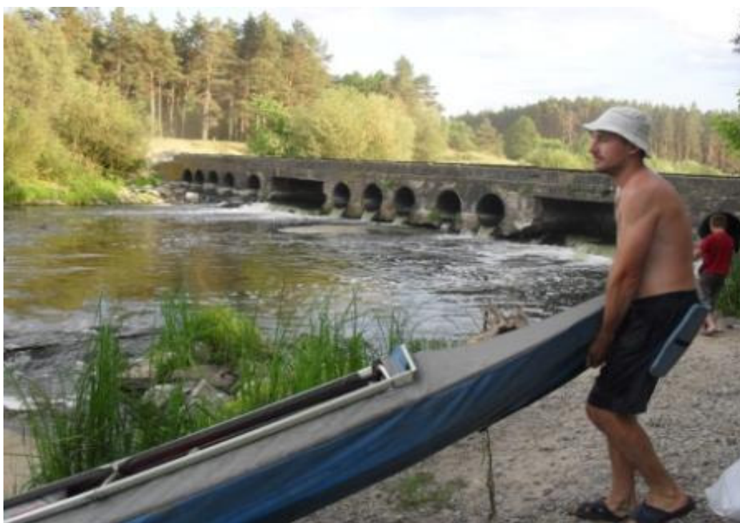
Фото 26 – Бетонный мост в п. Городское.
