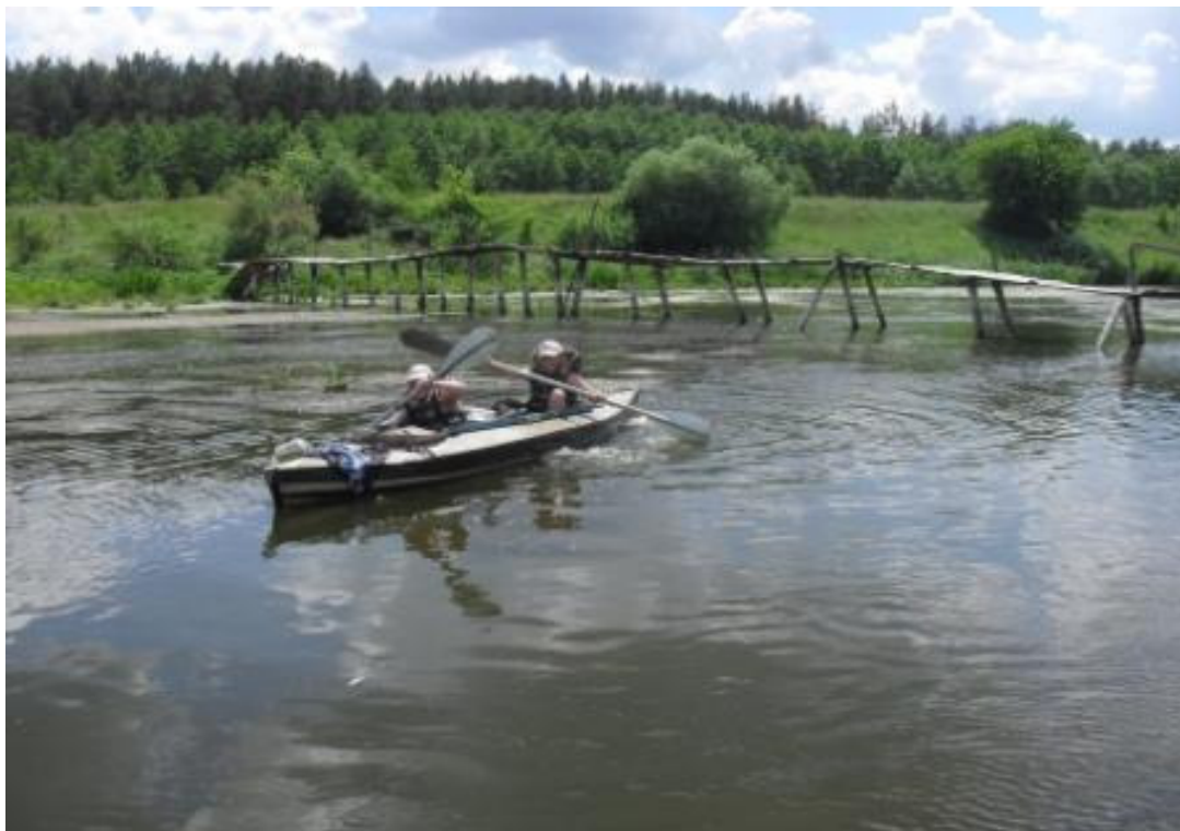
Фото 23 – п. Козиевка, деревянный мост через реку
