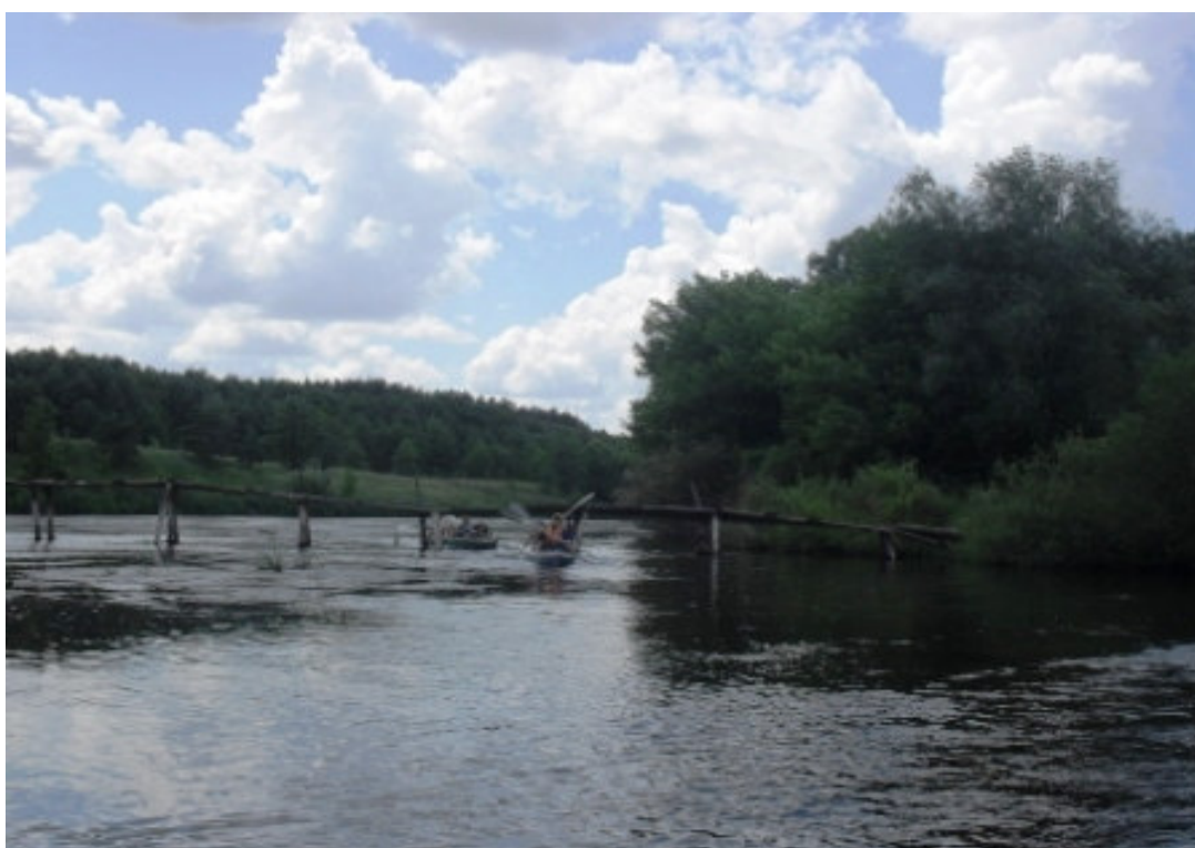
Фото 22 – п. Козиевка, деревянный мост через реку
