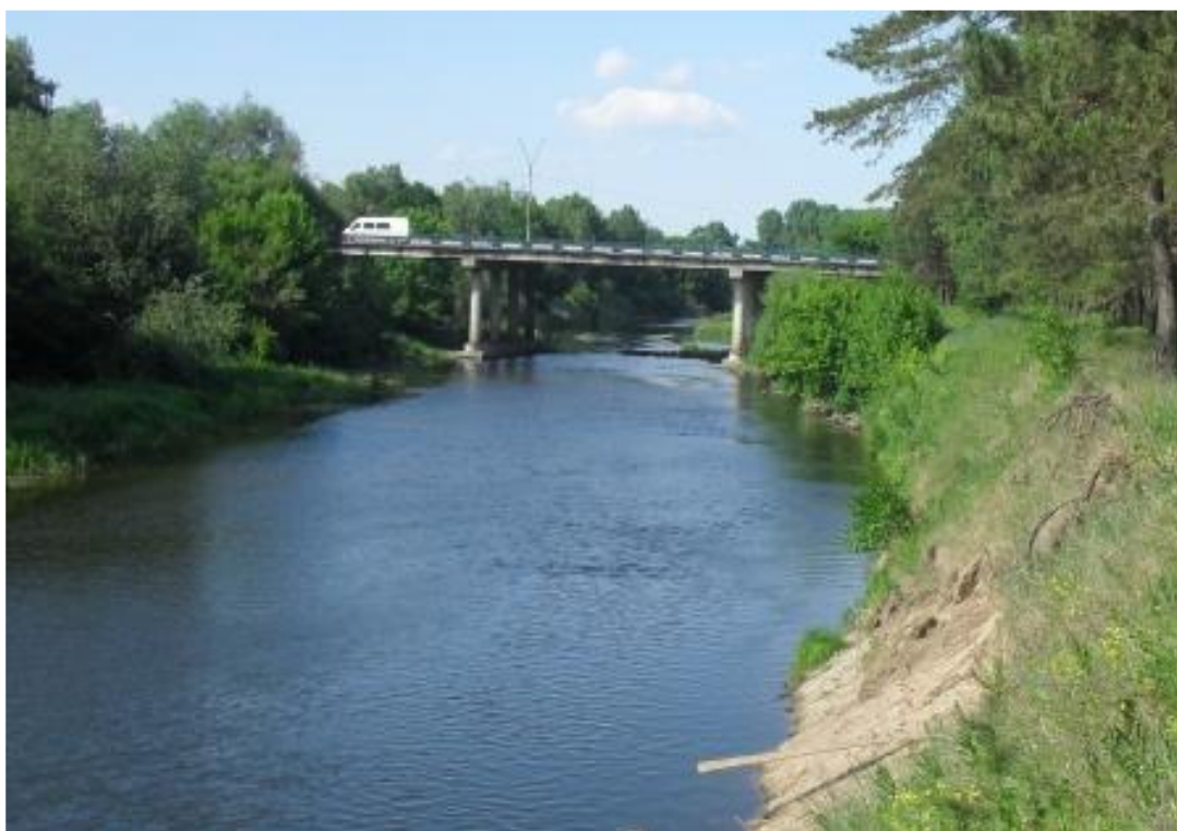
Фото 20 – Автомобильный мост через р. Тетерев
