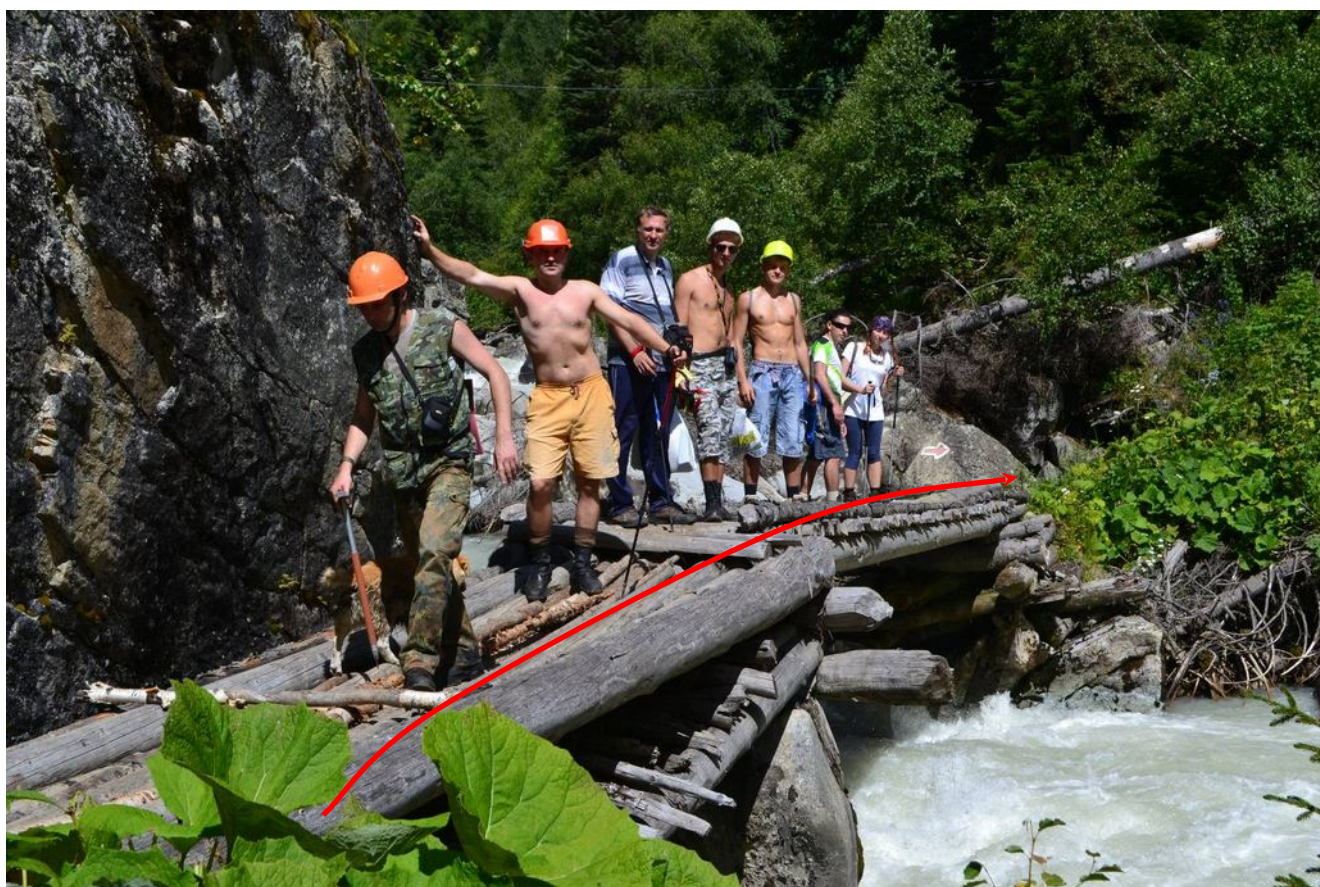
Фото 2. Міст через р. Долра біля прикордонної застави
