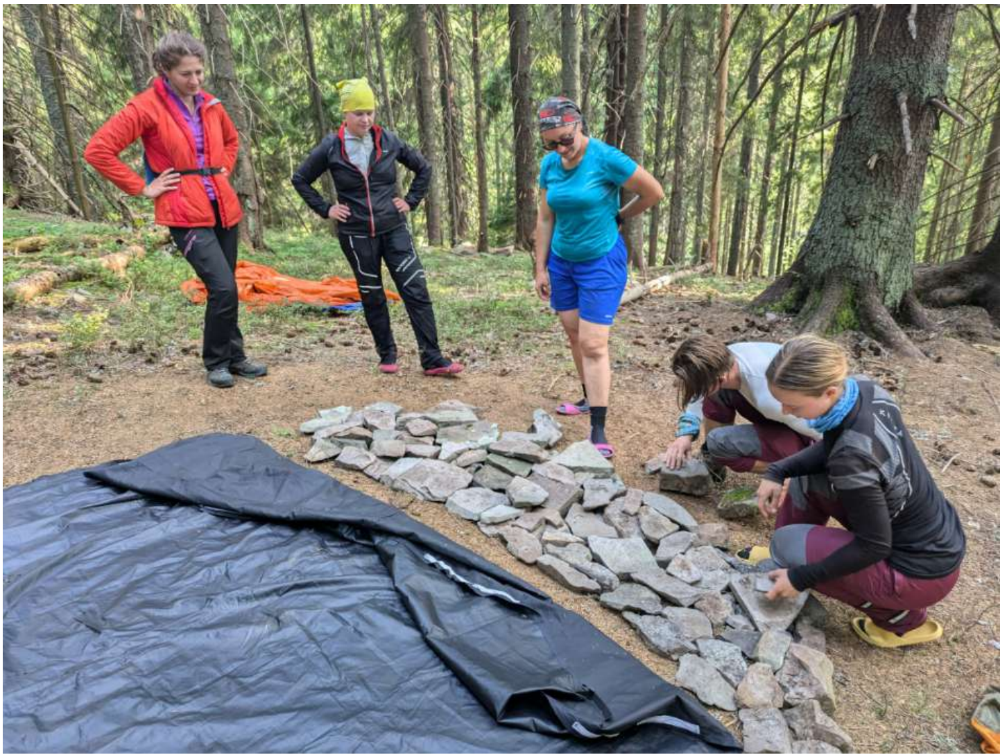
Фото 8.8. Конструювання майданчику під шатро на місці ночівлі
