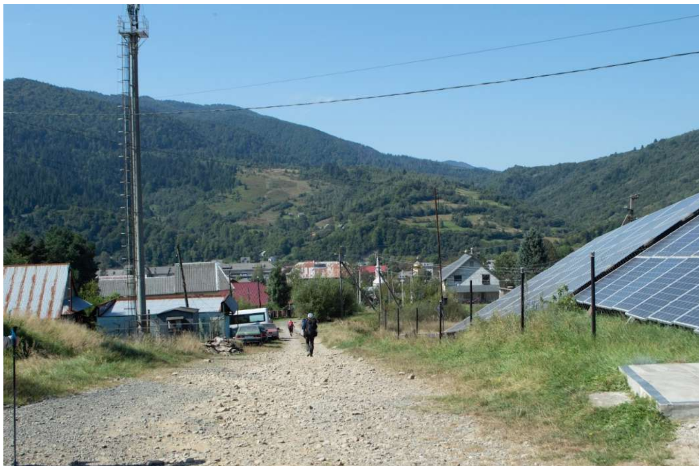
Фото 9.6. Ґрунтова дорога на підході до с.Межигір'я
