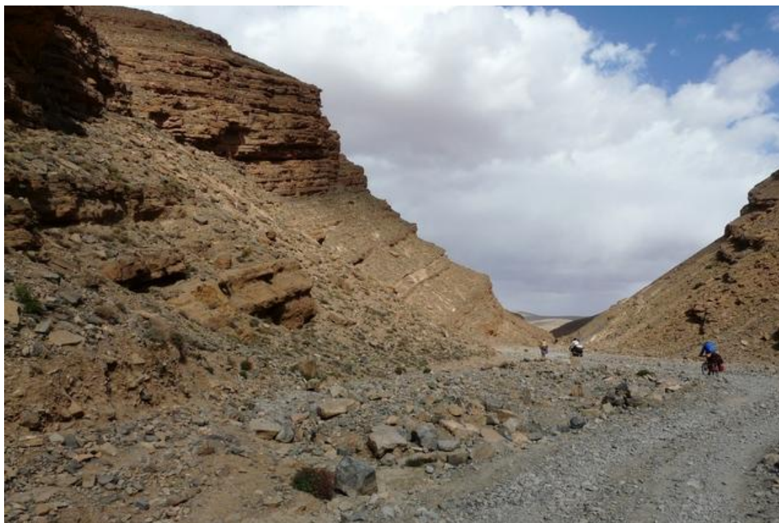
Фото № 46. Участок дороги от Мсемрир к г.прох.Тизи-н'Угерд-Зегзаун 2625м
