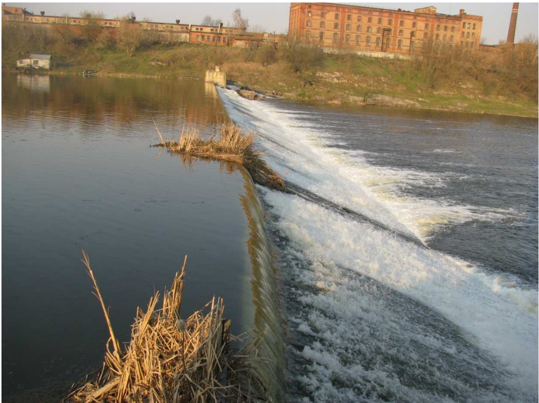
Фото 8. Плотина Сутиской ГЭС.
