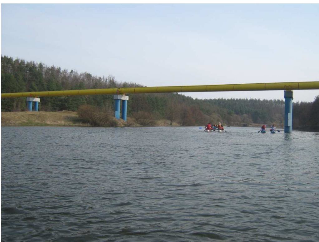
Фото 22. с. Стрельчинцы. Труба газопровода.
