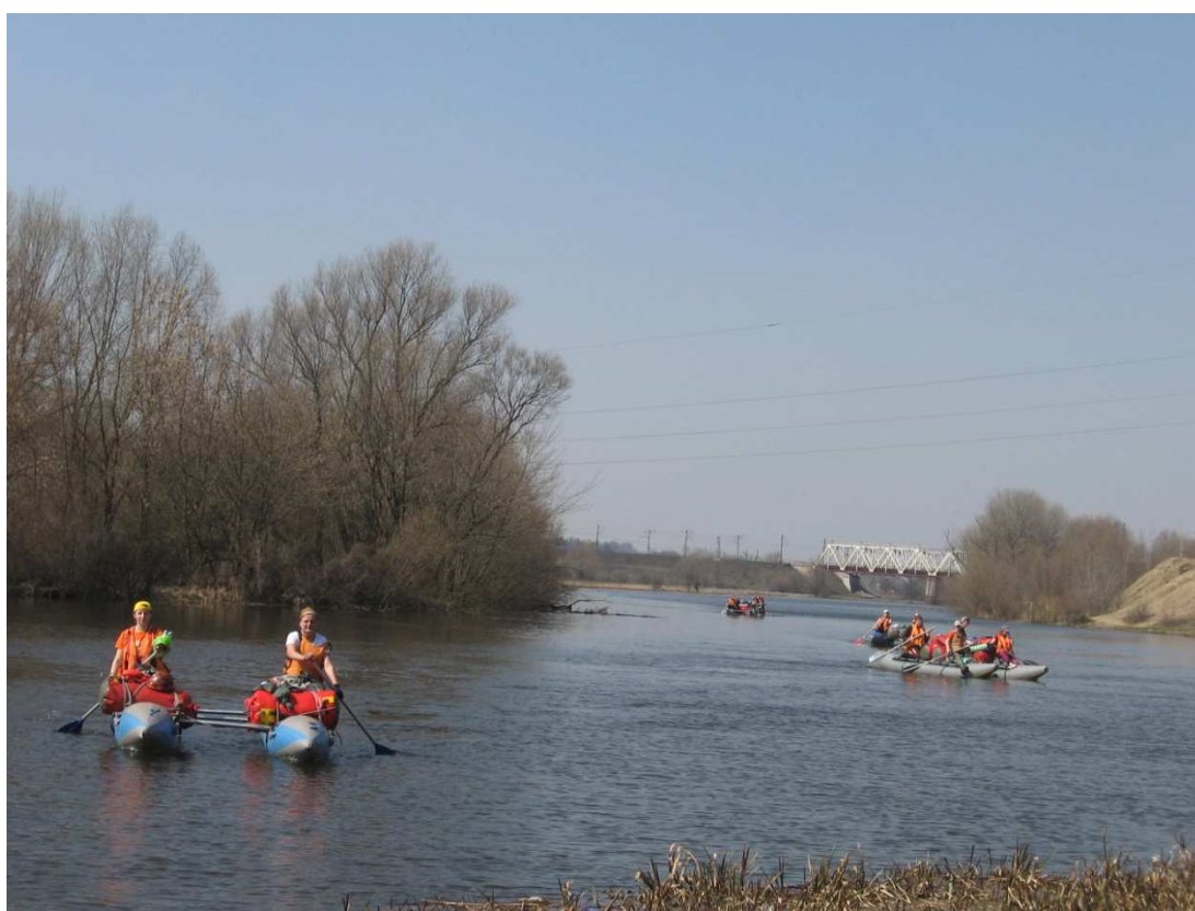
Фото 6. ж/д мост перед с. Гнивань.
