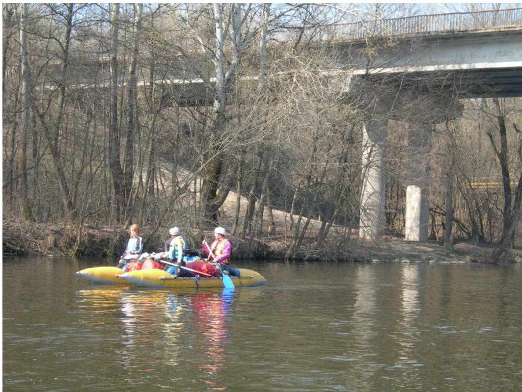
Фото 12. Автомобильный мост, газопровод.
