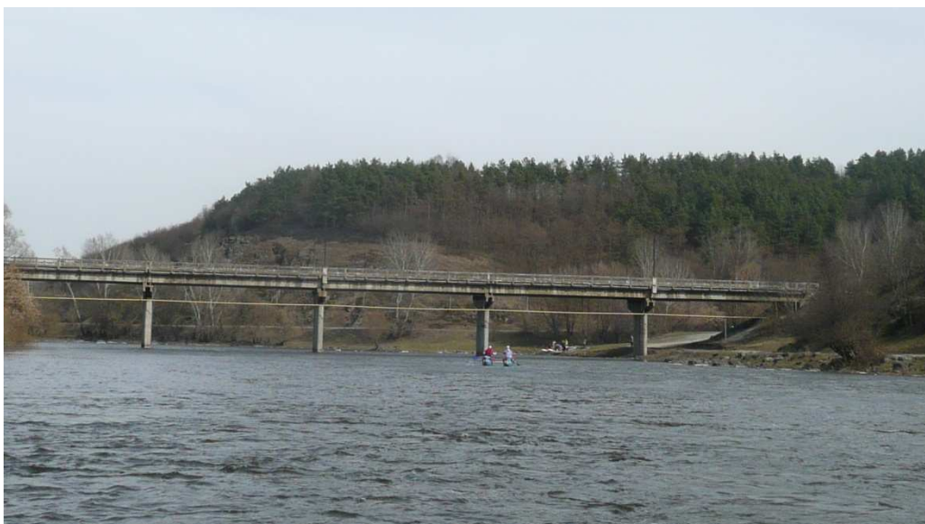
Фото 29. Автомобильный мост в с. Соколец.
